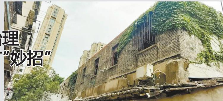
位于芜湖市镜湖区金马门社区的笆斗街小三楼建设于上世纪70年代,原为两层职工宿舍,后擅自加盖一层。该建筑临近街道,属人员聚集场所,存在较大安全隐患,市房屋安全鉴定处提出了降层改造处理建议,在保证房屋结构安全的前提下施工后,6月底,小三楼拆除了后期加盖的顶层,消除了危房安全隐患。
