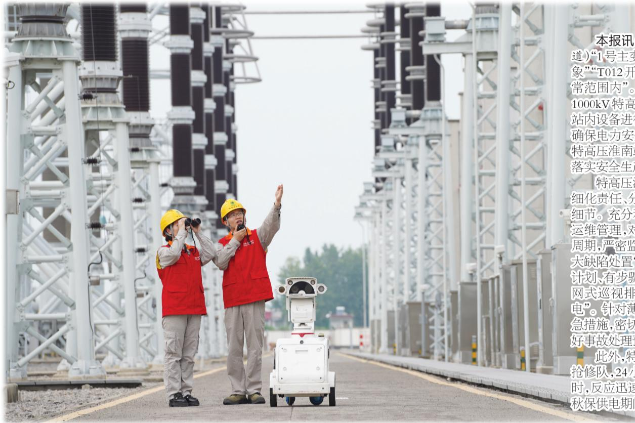
本报讯(记者 廖凌云 通讯员 刘甜甜 摄影报道)“1号主变压器温度正常,未发现过热等异常现象”“T012开关A相SF6气体压力为0.65MPa,在正常范围内”。9月12日,国网安徽电力超高压公司1000kV特高压淮南站运维人员坚守生产一线,对站内设备进行红外测温和特巡工作。中秋假期,为确保电力安全稳定外送、守护好万家灯火,1000kV特高压淮南站精心安排、周密部署,制定保电方案、落实安全生产、细化各项保电措施。
