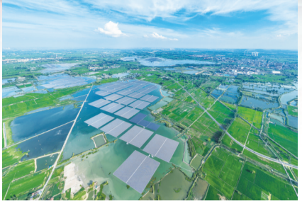
采煤沉陷区水面成为光伏新能源主战场。
