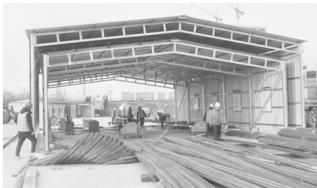
施工人员在钢筋操作棚内作业
