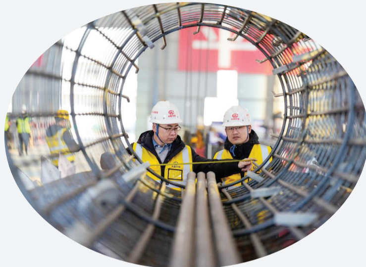
2月25日,在雄忻高铁雄保段一标段钢筋加工场内,中铁电气化局的施工人员检测钢筋质量。 新华社记者 牟宇 摄
