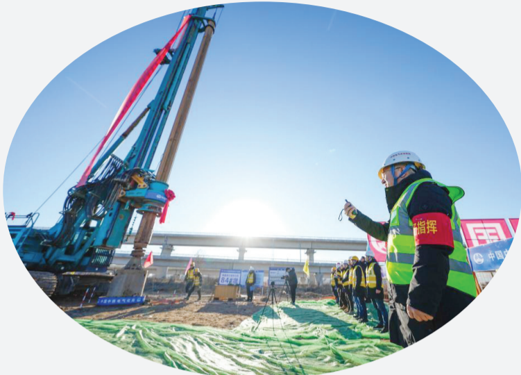
2月25日,中铁电气化局的施工人员在雄忻高铁新盖房特大桥建设现场指挥钻孔作业。 新华社记者 牟宇 摄
