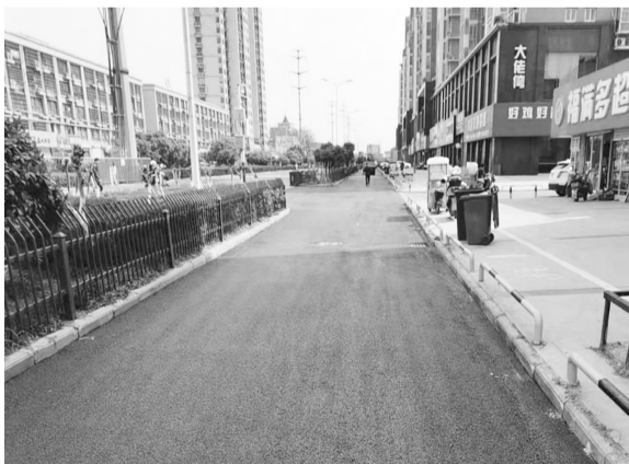
田家庵区部分新修路面
