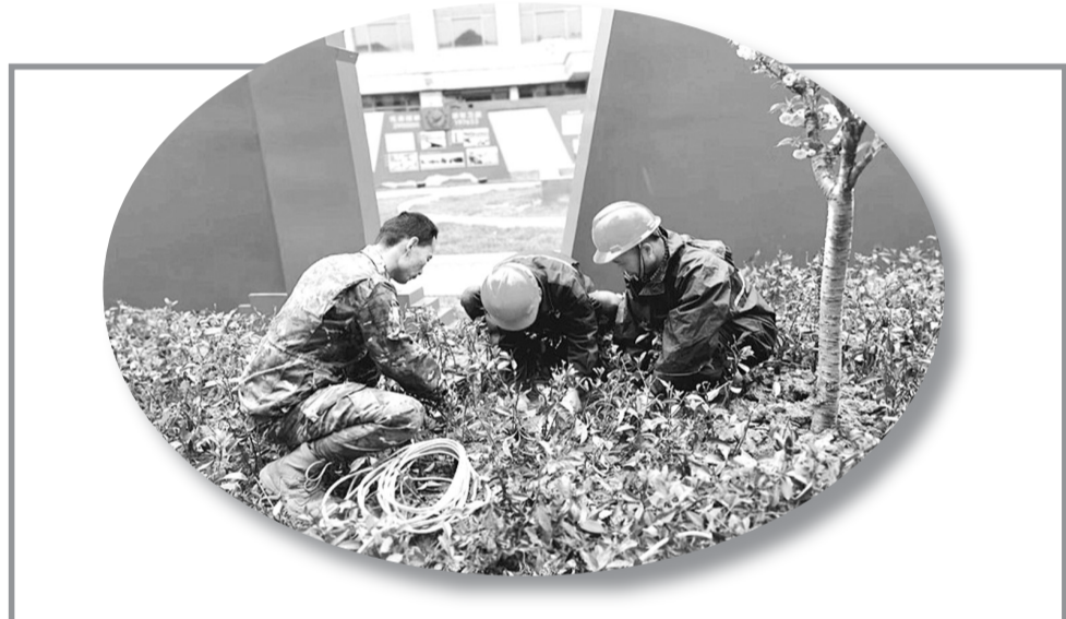
员工和官兵共同维修管道
