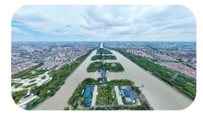
5月7日在江苏省扬州市拍摄的江都水利枢纽(无人机照片)。 该枢纽主要由4座大型电力抽水站、12座大中型水闸、3座船闸以 及输变电工程、引排河道等组成,共装机33台套,容量55800千瓦,是 目前我国规模最大的电力排灌工程、亚洲最大的泵站枢纽。
