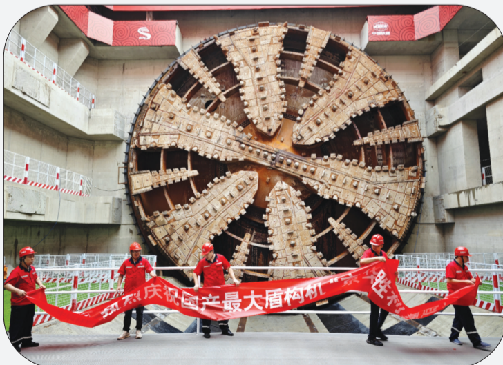
6月28日,国产最大直径盾构机——“京华号”盾构机出洞,由中铁十四局承建的北京东六环改造工程西线隧道顺利贯通。这是目前我国最长盾构高速公路隧道,标志着这一国家级创新工程取得重大进展。
