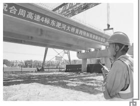
在地面人员的指挥下,通过操作龙门吊,将一片30米长的预制箱梁慢慢吊起后缓缓向墩柱移去,最后精准人位……8月3日上午,S16合周高速寿县刘岗至保义段4标东淝河大桥首跨预制箱梁顺利架设,标志着东淝河大桥引桥全面进入上部施工阶段。
