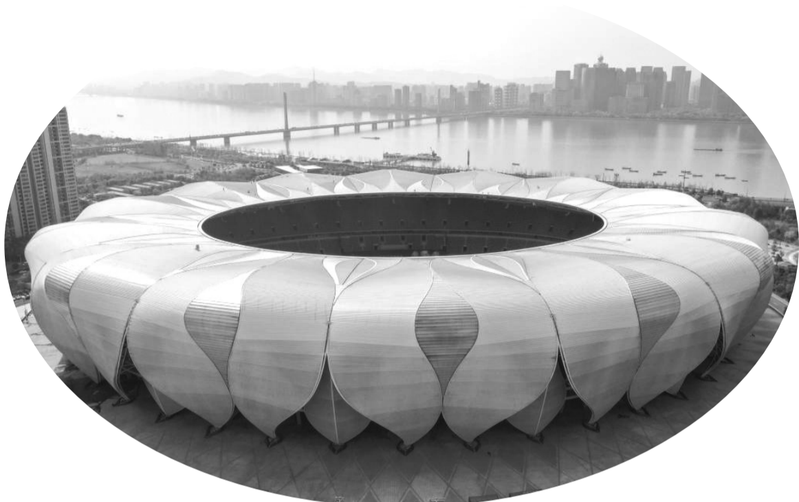
这是2022年3月30日拍摄的杭州奥体中心体育场(无人机照片)。2023年9月23日,杭州亚运会开幕式将在这里举行。 新华社记者 黄宗治 摄
