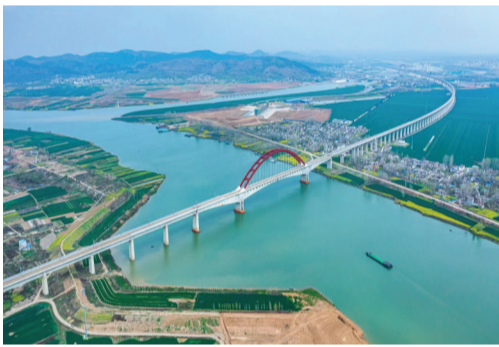
商合杭高铁淮河大桥
