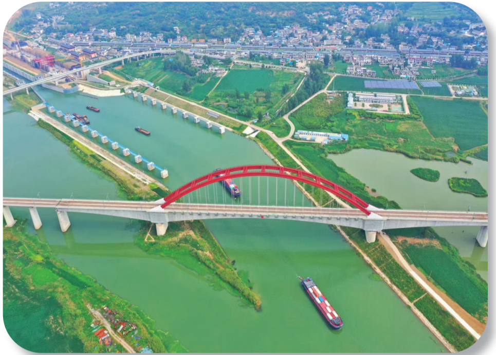
商合杭高铁东淝河大桥
