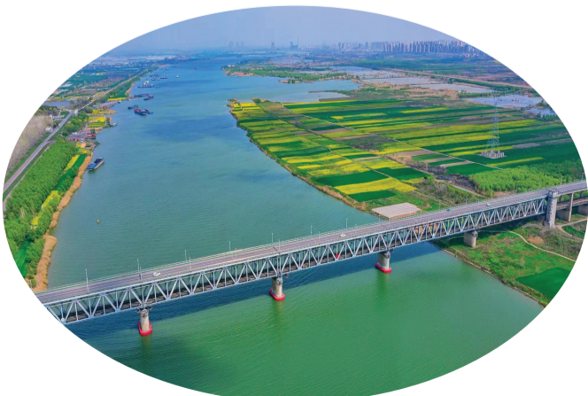
平圩淮河大桥
