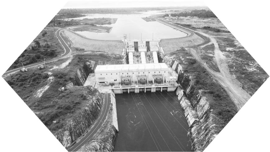
这是2023年8月15日拍摄的科特迪瓦苏布雷水电站厂房全貌。苏布雷水电站位于萨桑德拉河上纳瓦瀑布附近,由中国电建下属的中国水利水电第五工程局有限公司承建,总装机容量为275兆瓦,是科国家能源平衡战略核心项目。
