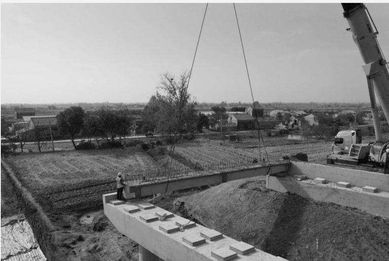
本报讯(记者 张明星 通讯员 郑捷 摄影报道)11月15日,随着首片预制T梁平稳精准地落在桥墩盖梁上,标志着S16合周高速寿县刘岗至保义段二标段预制梁架设正式拉开序幕。
