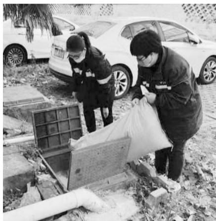
工作人员正在对水表井填充石英砂进行保温作业
