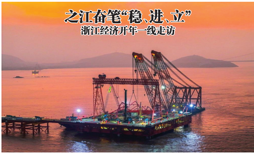
1月7日清晨,甬舟铁路西堠门公铁两用大桥5号主墩超大直径钻孔桩灌注施工现场,工人在浇筑最后一根钻孔桩。 新华社发(姚峰 摄)
