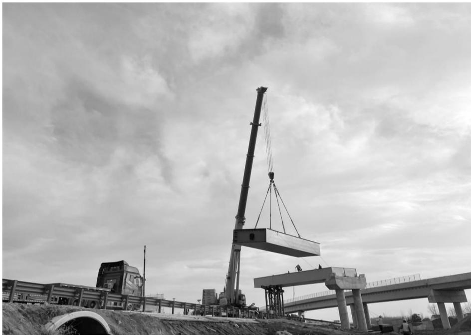
本报讯(记者张明星 通讯员 靳秦粤 焦俊君 摄影报道)1月15日,保义枢纽E匝道桥德上高速以东最后一榀钢箱梁架设完毕,标志着由淮南交控集团承建、中铁一局施工的S16合肥至周口高速公路3标段跨德上高速淮南至合肥方向钢箱梁全部架设完成,为后续保义枢纽互通立交桥桥面施工和护栏施工奠定基础。
