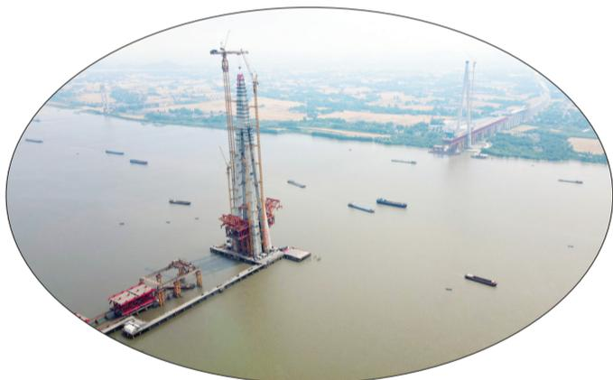
这是5月22日拍摄的巢马城际铁路马鞍山长江公铁大桥4号墩主塔(左)封顶施工现场(无人机照片)。
