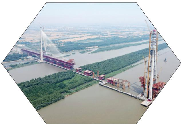
这是5月22日拍摄的巢马城际铁路马鞍山长江公铁大桥4号墩主塔(右)封顶施工现场(无人机照片)。
