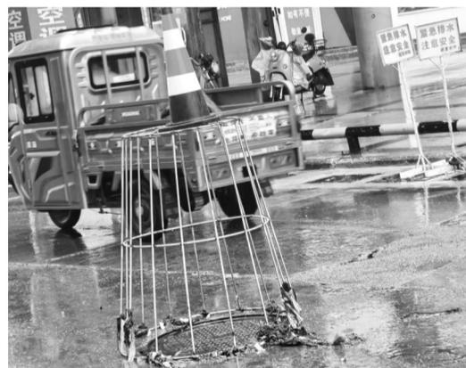
南建发市政工程公司等单位160余名市政排水人员坚守一线,在48条主次干道包保责任路段开展清理井篦阻水杂物、打开井盖(篦)应急排水、设置排水笼、警示标志并专人值守。同时,出动机械、车辆40余辆,调配4台应急泵车等对城区下穿桥、低洼地等适时强排,保障交通通行安全。
