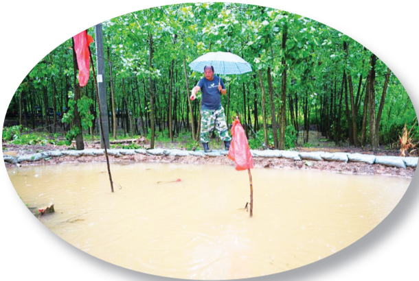
7月2日,夏尚喜正在查看前几日处理的一处管涌险情。 新华社记者 黄博涵 摄
