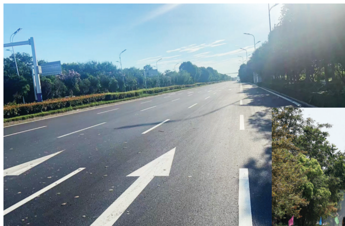
▲ 北侧车行道已经竣工通车 本报记者 廖凌云 摄
