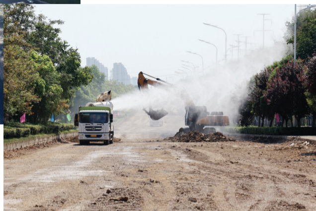
▼ 南侧车行道正在改造 本报记者 张越 摄
