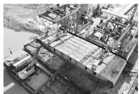
本报讯(记者 张明星 通讯员 耿一 鸣 郑海洋 摄影报道)S16合周高速淮南 段路基4标东淝河特大桥项目建设又 取得新进展。作为S16合周高速淮南 段控制性工程之一,9月9日,东淝河特 大桥主桥#1块钢箱梁顺利吊装,标志 着向主桥合龙又迈出坚实一步。
