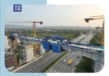
9月16日,西延高铁节点性工程——跨G30连霍高速公路连续梁顺利 合龙,为后续工程建设奠定基础。
