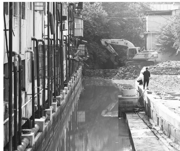
图为施工现场
