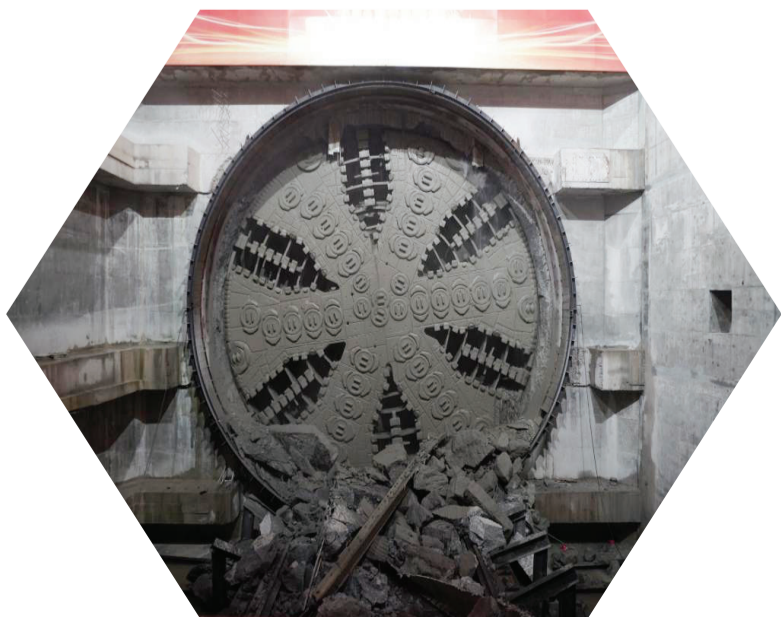
“皖江奋斗号”盾构机刀盘破洞而出,顺利抵达接收井。 (中铁十四局供图)
