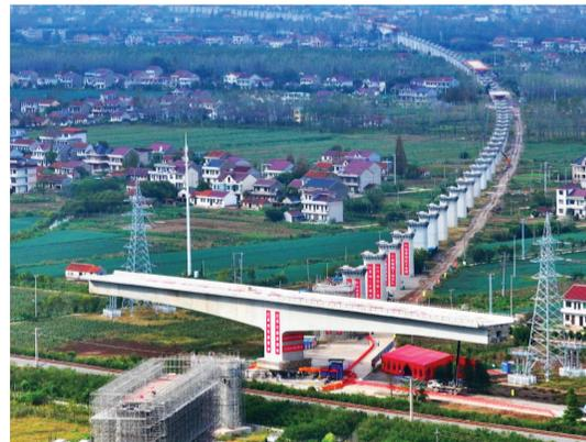
成转体全部施工工序,将梁体精准旋转到272和273号墩上,转体精度达到3毫米。
