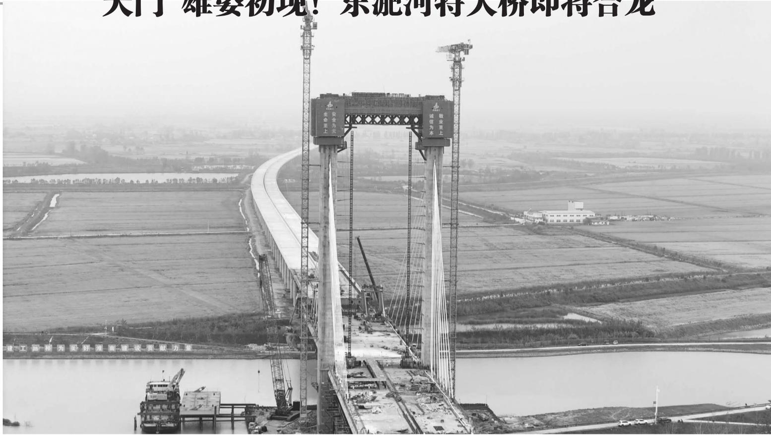
本报讯(记者张明星 通讯员耿一鸣 摄影报道)10月18日,淮河早报、淮南网记者从安徽建工路桥S16合周高速淮南段路基4标项目部获悉,目前,由安徽建工路桥承建的S16合周高速淮南段东淝河特大桥梁主塔主体结构施工基本完成,主桥钢箱梁也即将进入合龙段安装。
