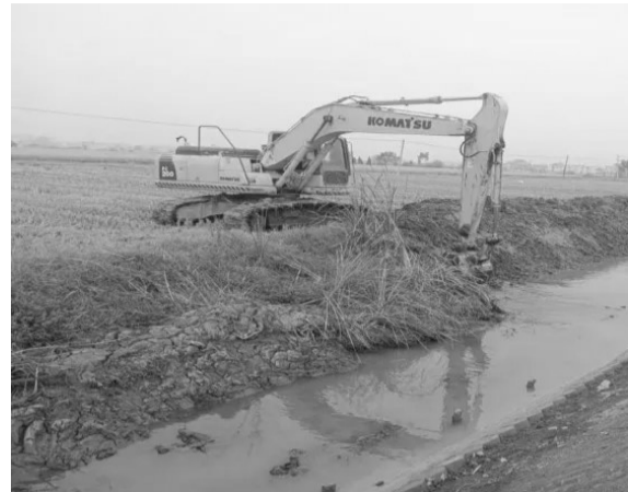
图为挖掘机正在清理河道淤泥和塘埂。
