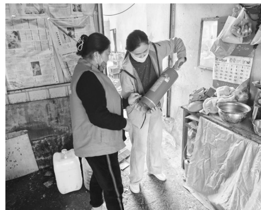
图为志愿者深入居民家中开展消防安全隐患排查。
