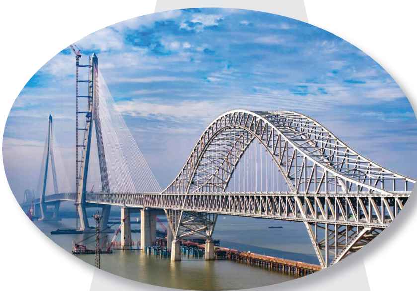
11月10日拍摄的建设中的常泰长江大桥(无人机照片)。
