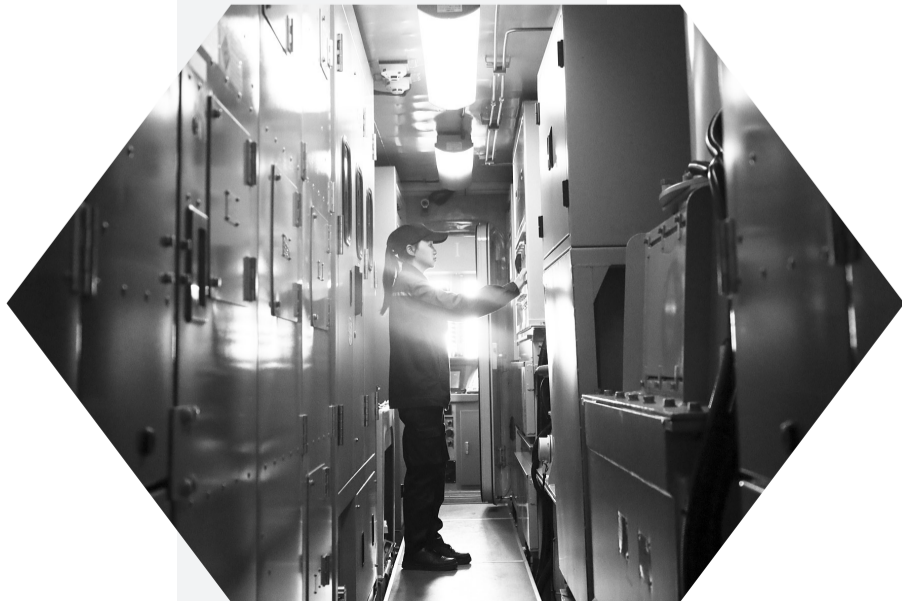
在中老铁路万象车辆运用检修车间内,老挝籍机车检修员彭梦雨进行检修工作。 新华社记者 摄
