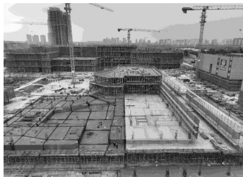
淮南人民公园城市综合体正加紧建设
