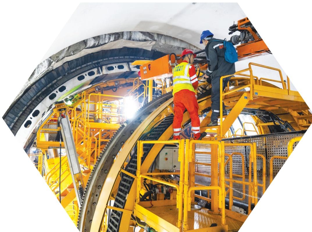
1月5日拍摄的引江补汉工程首台双护盾硬岩掘进机“江汉平安号”掘进施工现场。
