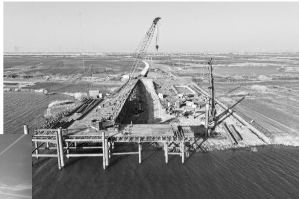
▲空中俯瞰淮南淮河大桥建设现场 ◀淮南淮河大桥建成效果图
