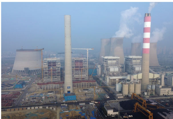
平圩电厂四期工程稳步推进，目前该项目主厂房区域进入内部安装阶段。
