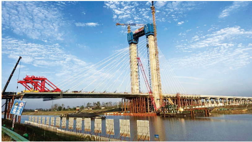
东淝河特大桥主桥合龙时的场景
