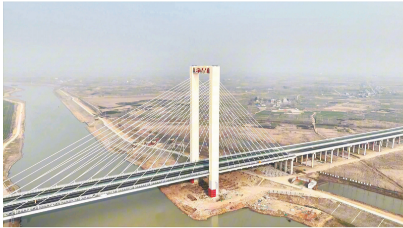
建成后的东淝河特大桥展现雄姿
