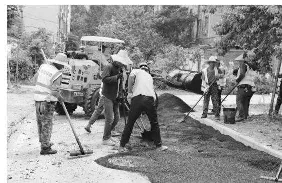
近日，田家庵区洞泉小区内，市政工程公司施工人员正顶着烈日进行柏油路面摊铺作业。伴随着压路机的匀速行进，滚烫的沥青路面逐渐平整，工人们配合机械设备有条不紊地推进施工，老旧小区改造工程进入路面硬化关键阶段。
