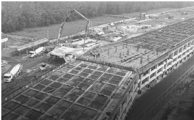
跨堤桥连接水域与陆地的引桥施工现场 李恒 摄
